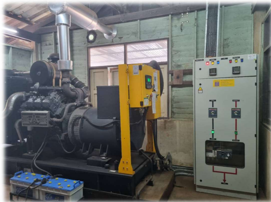
เครื่องกำเนิดไฟฟ้าขนาด 300 KV
